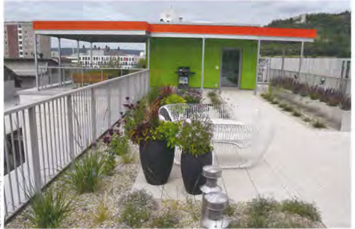
Dachterrasse in Jena auf einem Retentionsdach. Kombination Regenwasserrückhalt und Aufenthaltsfläche.
